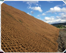
Erosionsschutz aus Jute- od. Kokosfasern
