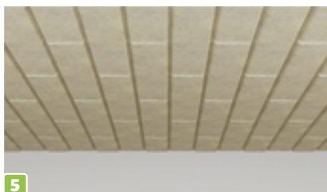
Bei Nutzung nur als Stauraum reicht oft schon die einfache Heck Ceilrock Top mit glasvlieskaschierter und damit bereits fertiger Oberfläche (Abb. 4). Für höheren Anspruch an Raumgestaltung gibt es Stroprock – eine Lamelle mit umlaufender Fasse (Abb. 5).
