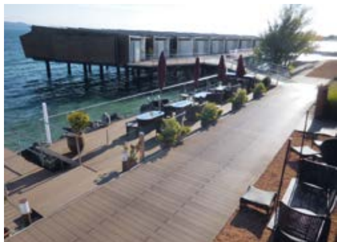
Bei Hotelanlagen sind die höheren Anforderungen und Belastungen zu beachten.
