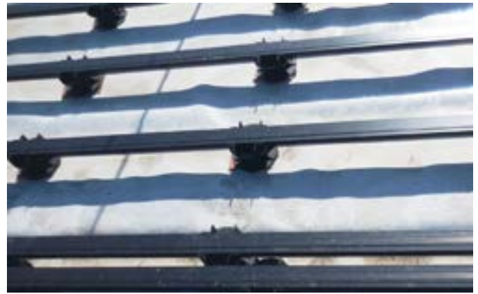
Aluminiumunterkonstruktion werden oftmals mit Verstellfüßen als System angeboten und müssen nur eingeklickt werden.
