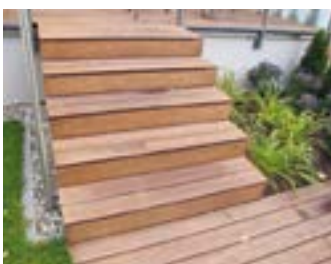
Treppe > 60 cm Höhe
