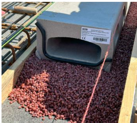
MEAKERB BRIDGE mit durchgängiger Dichtungslippe verhindert das Einsickern von Wasser in das Bauwerk
