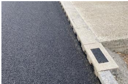
Kombination aus Entwässerung und Schrammbord schafft mehr Platz für die Fahrbahn
