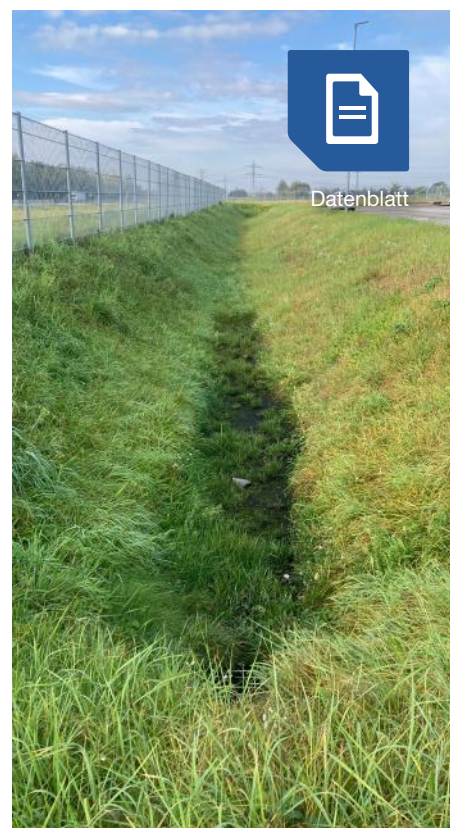
Grünmulden mit technischem Filtersubstrat halten Schadstoffe von Verkehrsflächen dauerhaft zurück
