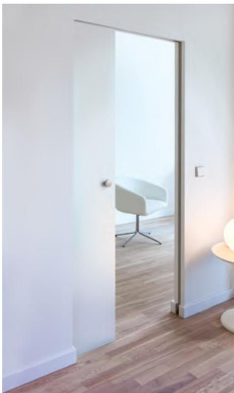
Mit dem neuen Schiebetür-System Pocket Kit Easy vereinfacht Knauf das Handling auf der Baustelle und beschleunigt die Montage. Die stabilen Stahl-Ständerprofile mit Traversen lassen sich vormontieren und leicht in die Wandkonstruktion einstellen. Die Tür läuft beim Öffnen im Wandhohlraum der Trockenbauwand. Die eloxierte Laufschiene ist integriert und sieht auch bei offener Tür gut aus.
