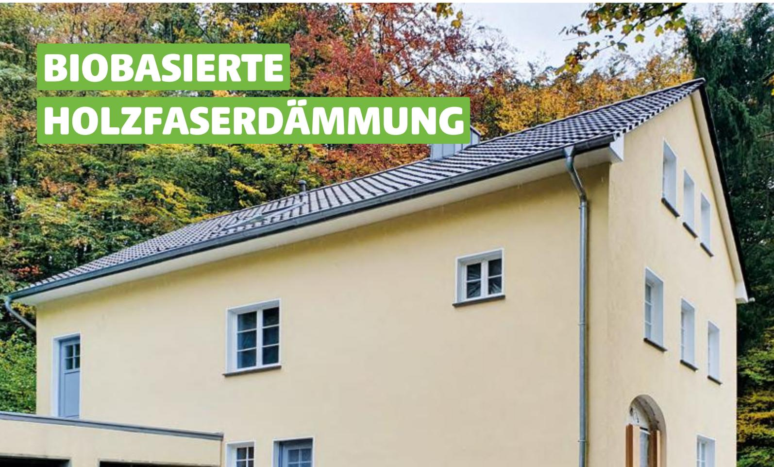
Baumaterialien aus Holz sind wie Ziegel Naturbaustoffe, langlebig und atmungsaktiv. Wärmedämmverbund-Systeme auf Holzfaserbasis ertüchtigen Häuser mit Ziegelmauerwerk energetisch. Durch die Kombination der Naturbaustoffe bleiben zudem Vorteile wie der diffusions-offene Aufbau der Außenwand erhalten.
