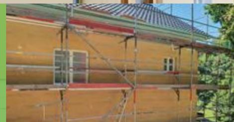
Mit der STEICOprotect 037 Holz-faser-Dämmplatte im WDVS lassen sich erforderliche Werte für Förderprogramme erreichen. Bei 160 mm Dämmstärke verbessert sich der U-Wert bspw. um über 80 %. Die Platten sind dauerhaft dampf-durchlässig und wasserabweisend. Feuchtigkeit wird nicht eingesperrt und kann abtrocknen.
