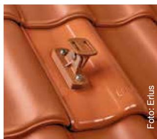
Das qualifizierte Dachhandwerk verfügt über professionelle Montage-Systeme, die geprüfte und zertifizierte Sicherheit garantieren: Befestigungspfannen, Modulstützen, Schienensysteme, Solardurchgangsziegel für die Kabelführung ins Innendach für höchste Regeneintragssicherheit u. v. m.
