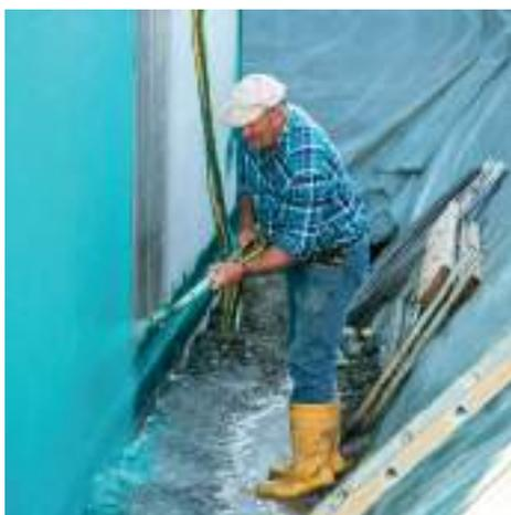
Die einkomponentige Reaktivabdichtung Botament RD1 Universal kann auch bei hohen Temperaturen von bis zu 35 °C verarbeitet werden. Außerdem entfällt das lästige Anmischen. Eventuell benötigte Teilmengen können leicht entnommen werden.
