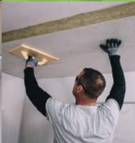
ISOVER Deckendämmplatten werden einfach von unten an die Tiefgaragen- oder Kellerdecke geklebt oder gedübelt. Sie sind sowohl bei der Verarbeitung als auch im verbauten Zustand gesundheitlich völlig unbedenklich, was der Blaue Engel belegt. Höchste Sicherheit gewährleisten die Platten auch im Brandschutz – mit dem Schmelzpunkt von > 1.000 °C.
