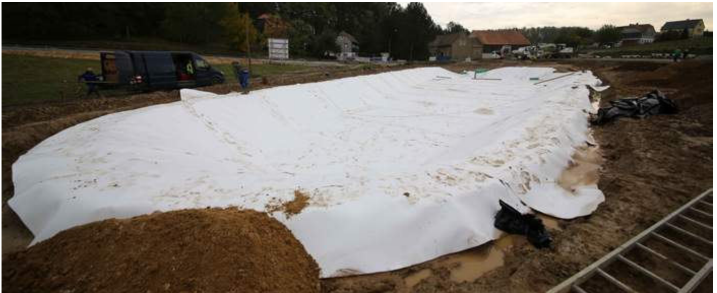
Baustellenansicht mit eingebauter TPD
