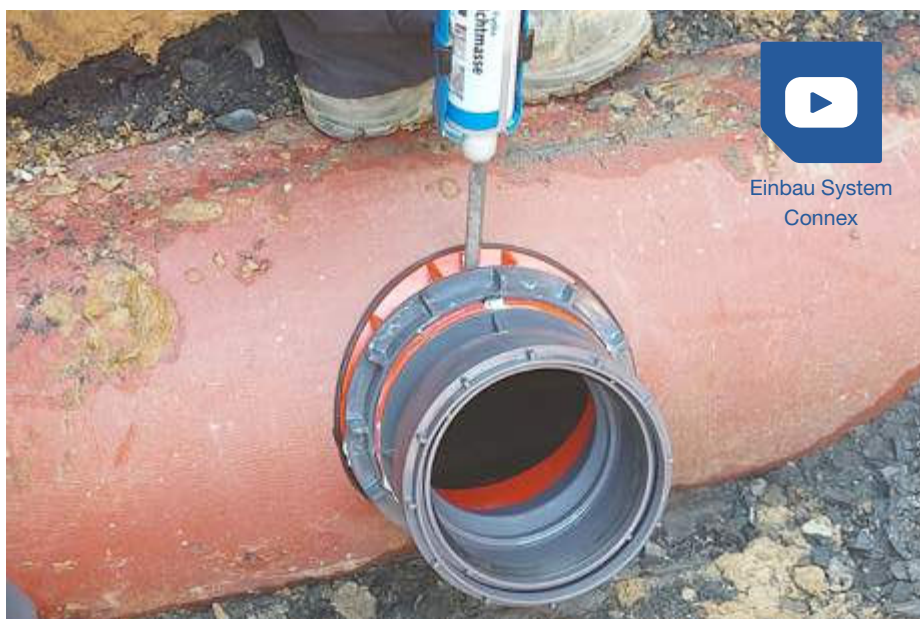
Je nach Witterung ist die Endfestigkeit der dauerelastischen Dichtmasse nach 50 – 70 Minuten erreicht
